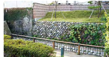
枯木橋詰遺構
